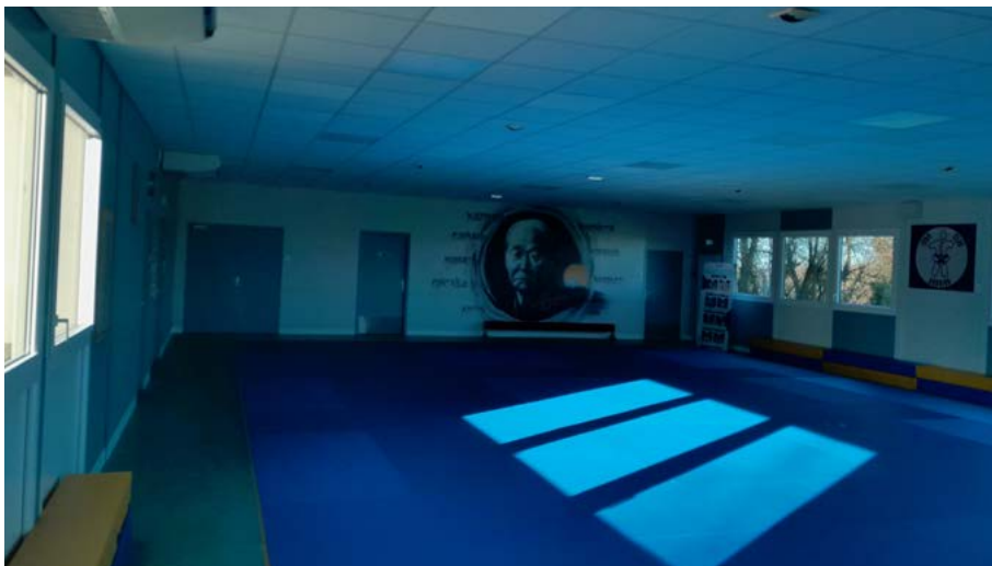
Salle Multi-Associative : installation du dojo, changement des menuiseries, installation d'une pompe à chaleur
